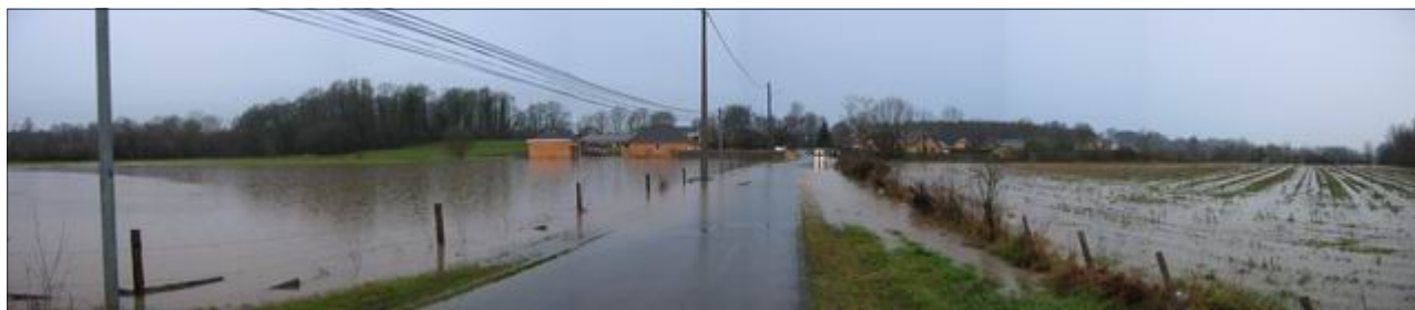
La rue de l'Aussère inondée . Au fond les maisons au pied de l'eau. (photo prise depuis le pont le 11/2/09)
