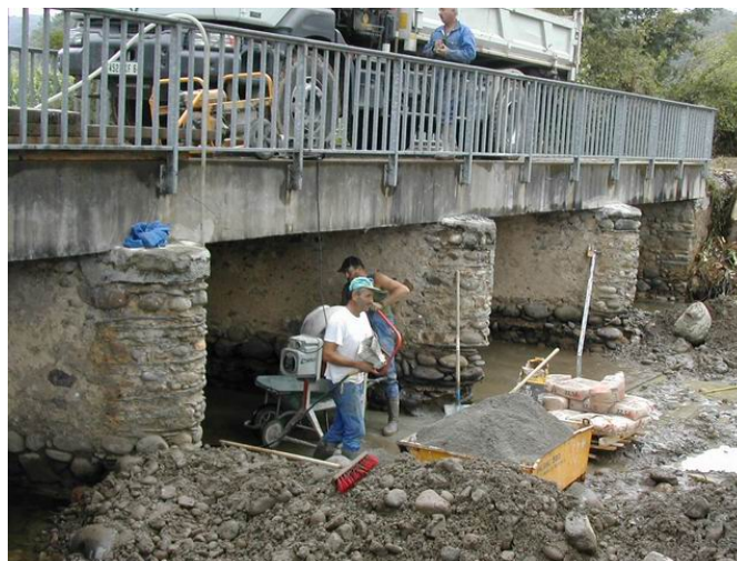
Le pont de La Palanque en travaux
